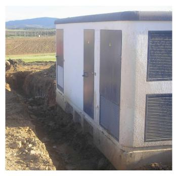
el criterio establecido por la normativa EN 60529, la envolvente exterior de hormigón se cataloga con un grado de protección IP339; excepto las rejillas de ventilación, cuyo grado de protección es IP239.
