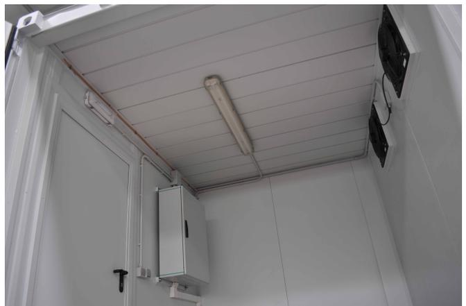
Junto al compartimento del transformador de potencia también se instalan dos **rejillas para favorecer la ventilación natural**. Si la potencia a disipar es muy alta se puede instalar un extractor adicional para su refrigeración.
